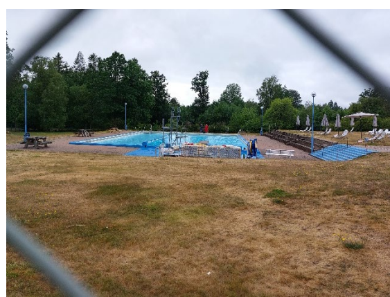
Befintlig utomhussimbassäng inom campingområdet
