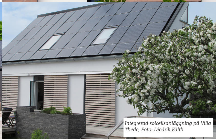
Detaljbild på takintegrerad solcellsanläggning med takfönster på Villa Thede, Foto: Catrin Andersson
